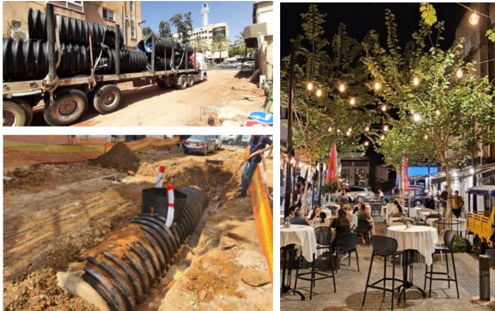
ביצוע פיילוט, רחוב השוק נטיעת עצים בצינורות שתילה tree tube
